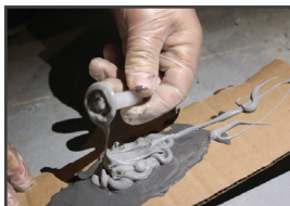
01 : Enrolle el borde en Pasta Epóxica de Anclaje de Alta Resistencia
