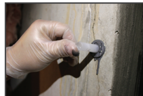
02 : Presione el punto firme sobre la grieta
